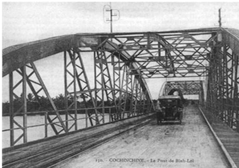
Cầu đường sắt-đường bộ Bình Lợi ở miền Nam năm 1910 1
